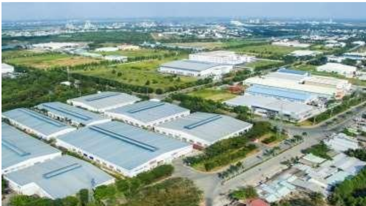
KHU CÔNG NGHIỆP LONG HẬU
