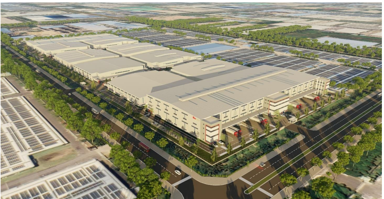
DỰ ÁN NHÀ XƯỞNG XÂY SẴN - BKIM
