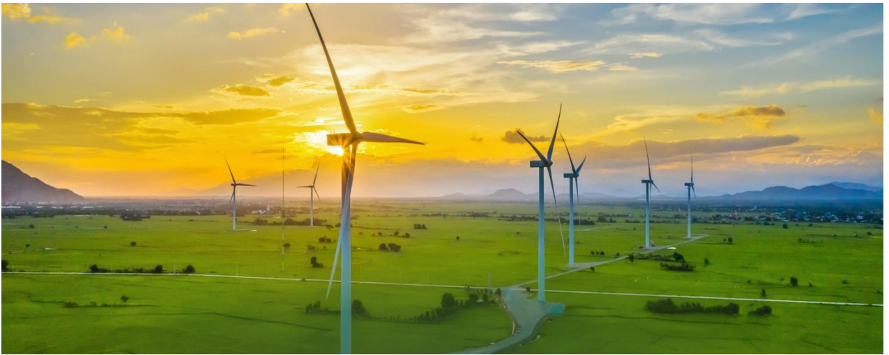
DỰ ÁN NHÀ MÁY ĐIỆN GIÓ HÒA ĐÔNG 2
